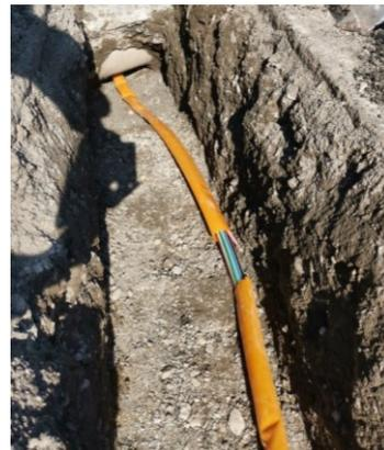
Abb. 2: Offener Graben mit Microrohren in Schlauch
